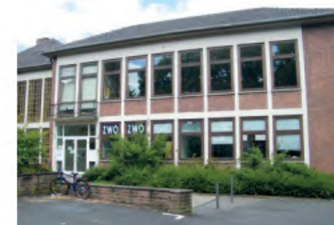
Das ehemalige Rathaus in der Koblenzer Straße 22 wird zum Stadtteilzentrum.
