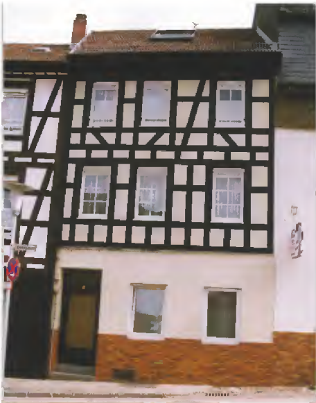
▶ Dreigeschossiges Fachwerkgebäude in der Altstadt (Franz-Neff-Platz)
