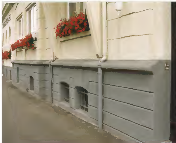
▶ Deutlich abgesetzter Gebäudesockel
