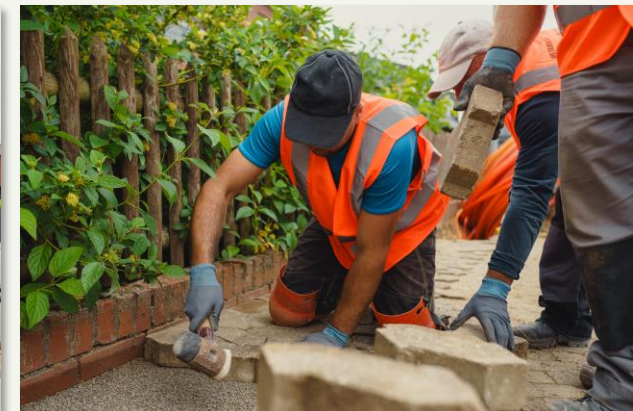
Nach Glasfaser-Ausbauarbeiten Wiederherstellung Ursprungszustand
