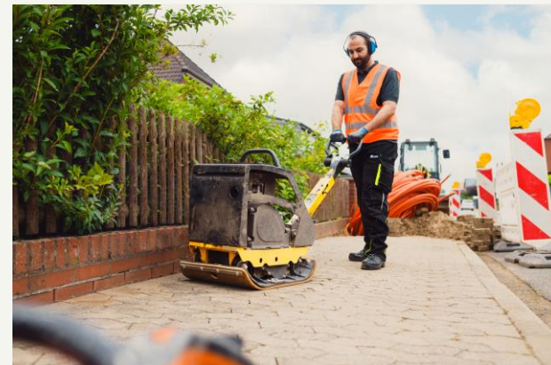
Nach Glasfaser-Ausbauarbeiten Wiederherstellung Ursprungszustand
