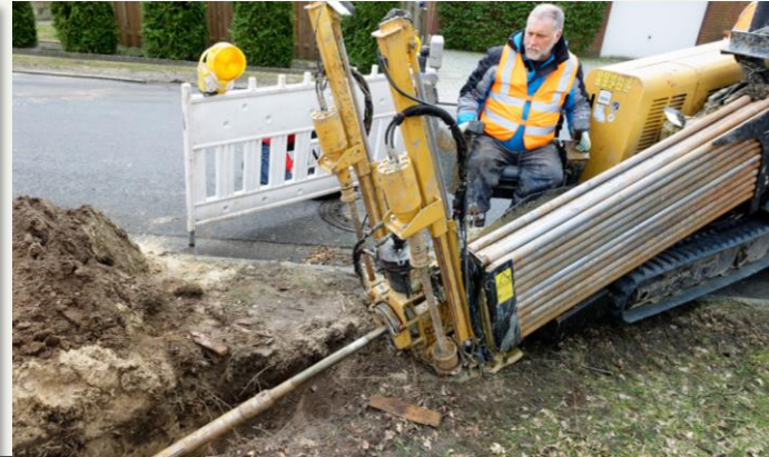
Spül-Bohr-Verfahren
