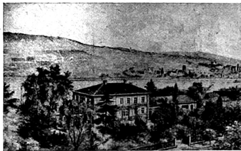
VILLA EDEN, MAINZERSTRASSE 51, BINGEN
