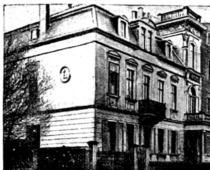
HAUS MAINZERSTRASSE 66, BINGEN
