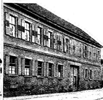
HAUS RÖMERSTRASSE 16, BÜDESHEIM
