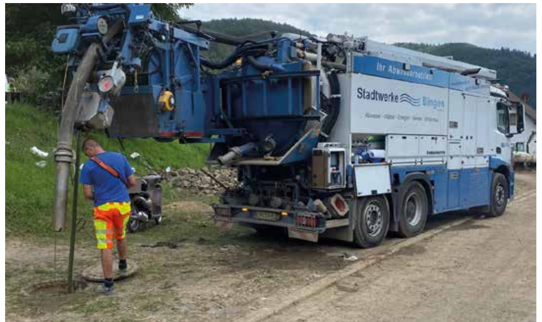
Der Spülwagen der Stadtwerke im Einsatz in den Dörfern an der Ahr.
