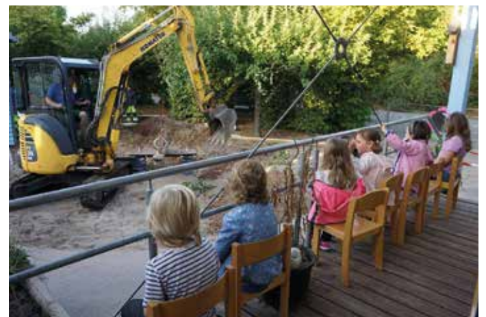
Die Kita-Kinder beobachten gespannt die Arbeiten zum Aufbau der neuen Schaukel. Foto: Stadt Bingen
