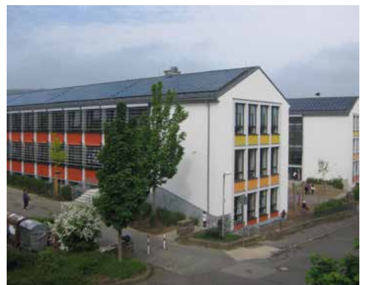
Das Dach der Grundschule an der Burg Klopp ist mit Photovoltaik-Anlagen ausgestattet. Foto: Stadt Bingen
