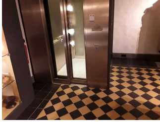
Aufzug Einstieg Ausstellungsraum "Stadtgeschichte"
