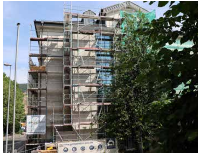
Aktueller Stand der Baumaßnahme Ende Juni 2023.
