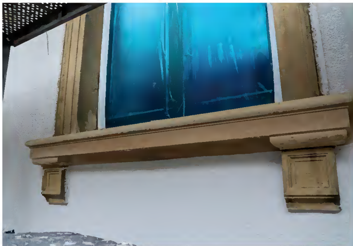
Die Sandsteinarbeiten am Gebäude sind äußerst aufwendig zu renovieren gewesen. Foto: Stadt Bingen
