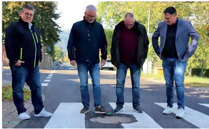
Bürgermeister Ulrich Mönch, Michael Wolff, Heinz Steinbrecher (beide Abteilung Straßenbau) und Werksdirektor Marco Mohr (v.l.) überzeugten sich von den gelungenen Sanierungsarbeiten in der Rochusallee.
