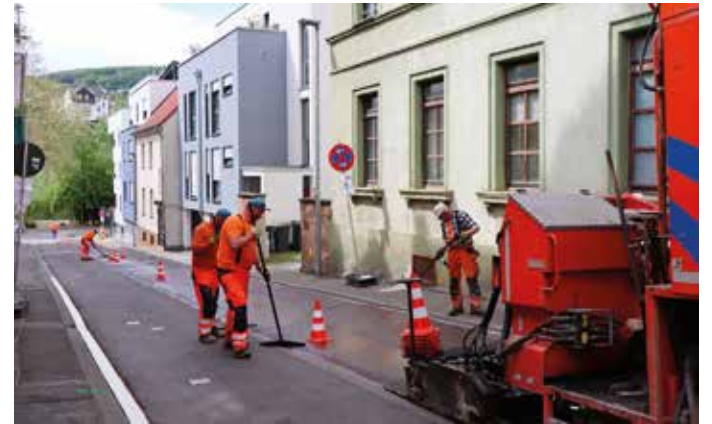
Laufende Sanierungsarbeiten in der Schloßbergstraße.
