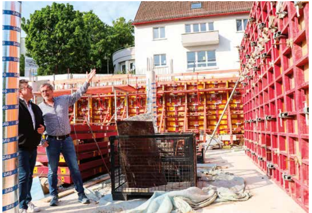
Ulrich Mönch (li.) und Jörg Gratz auf der Baustelle des neuen Familienzentrums.
