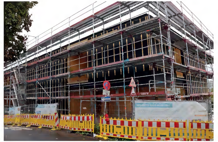
Der Rohbau steht.
