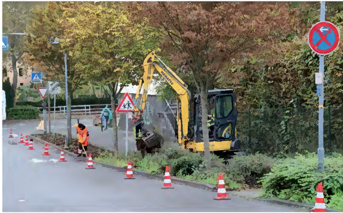
Erst die Rodungsarbeiten...
