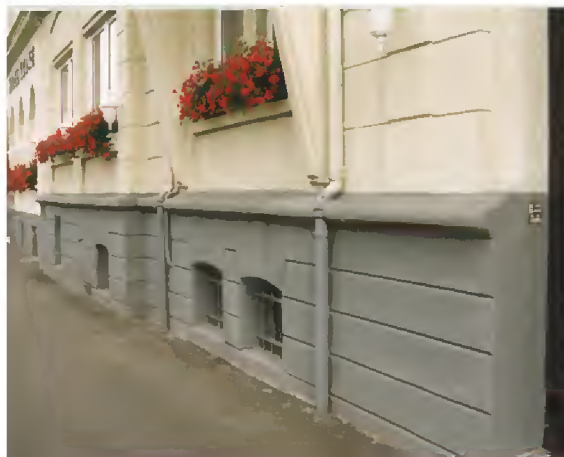
▶ Deutlich abgesetzter Gebäudesockel
