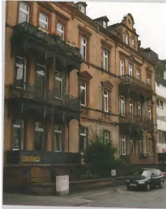
► Balkone an Gründerzeit-Gebäuden (Mainzer Straße)
