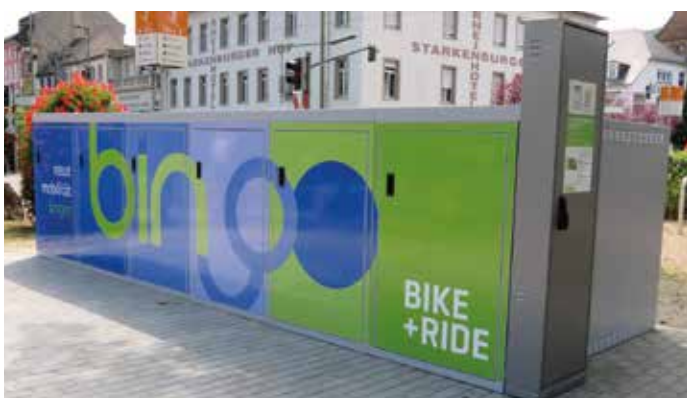
Die Bike&Ride-Boxen am Bahnübergang. Foto: Stadtwerke Bingen
